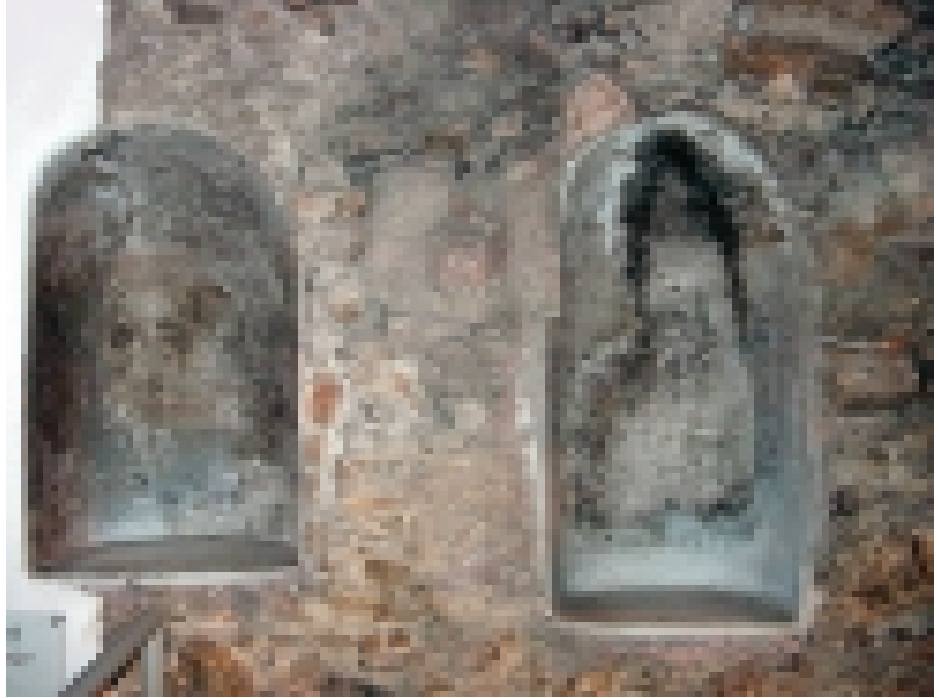
FOTOGRAFIA 12 – Nichos côncavos embutidos na parede da bateria de fornos da Casa da Moeda do Rio de Janeiro, em momento posterior à sua construção original, na forma estilizada do Templo de Salomão. Paço Imperial, Rio de Janeiro. Fotografia de T. Andrade Lima.
